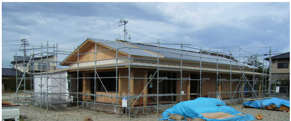
ギャラリー建築現場の様子
