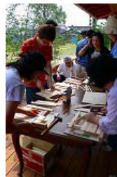
定規を使って板を等間隔に打ち付けます。
